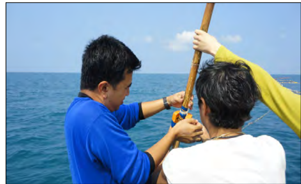
การติดตั้งเครื่องวัดกระแสน้ำ
