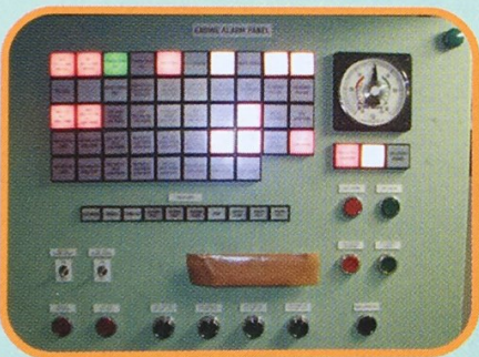
▲ แผงแสดงการทำงาน และแจ้งเตือนเครื่องจักรต่างๆ
